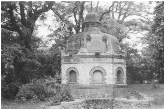
Das Brunnenhaus am Gesundbrunnen ca. 1950
